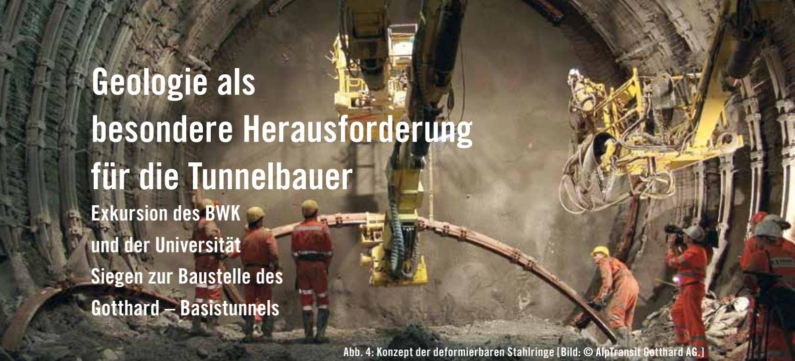
Abb. 4: Konzept der deformierbaren Stahlringe [Bild: © AlpTransit Gotthard AG.]
