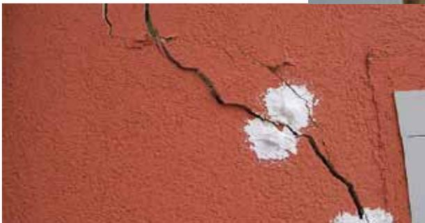
**Die kleine Stadt Staufen im Markgräfler Land bei Freiburg wurde zum Sinnbild der Risiken bei der Gewinnung von Energie aus tieferen Erdschichten. In Folge der Bohrung stieg Wasser in höhere Schichten und drang in Anhydritlager unter der Stadt ein, die seitdem aufquellen und die Stadt anheben - bislang um einen halben Meter (siehe Grafik). Viele Häuser in der historischen Innenstadt sind von zentimeterbreiten Rissen durchzogen und teilweise im Bestand gefährdet.**
