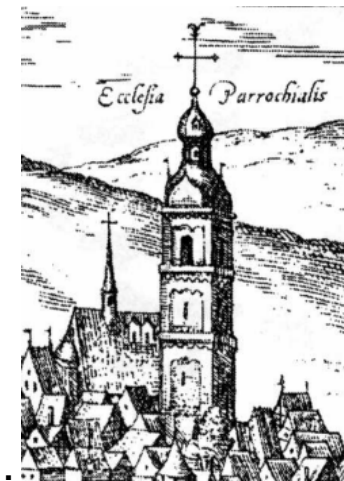
ABB. 2-5: KIRCHTURM VOR DEM UMBAU
