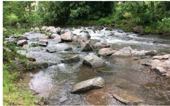
Abbildung 18: Sohlgleite der Kahl
