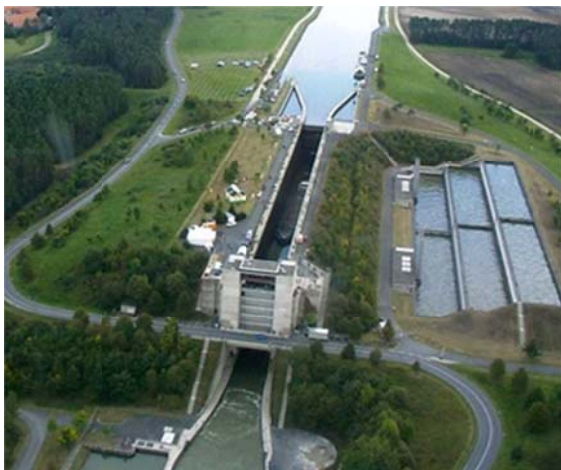
Abbildung 15: Schleuse Eckersmühlen am Main-Donau-Kanal [6]
