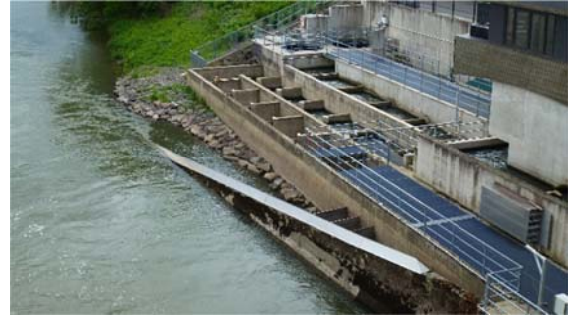
Abbildung 5: Fischpass der Moselstaustufe in Koblenz
