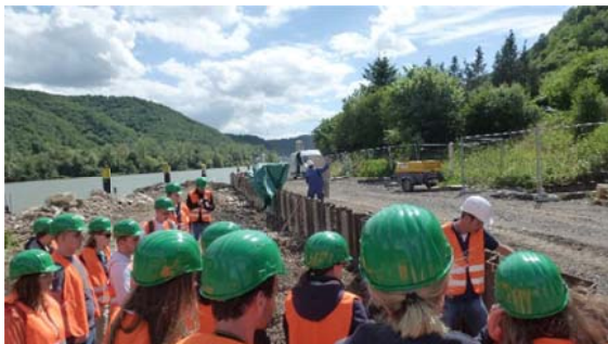
Abbildung 7: Baustellenbesichtigung der Moselschleuse
