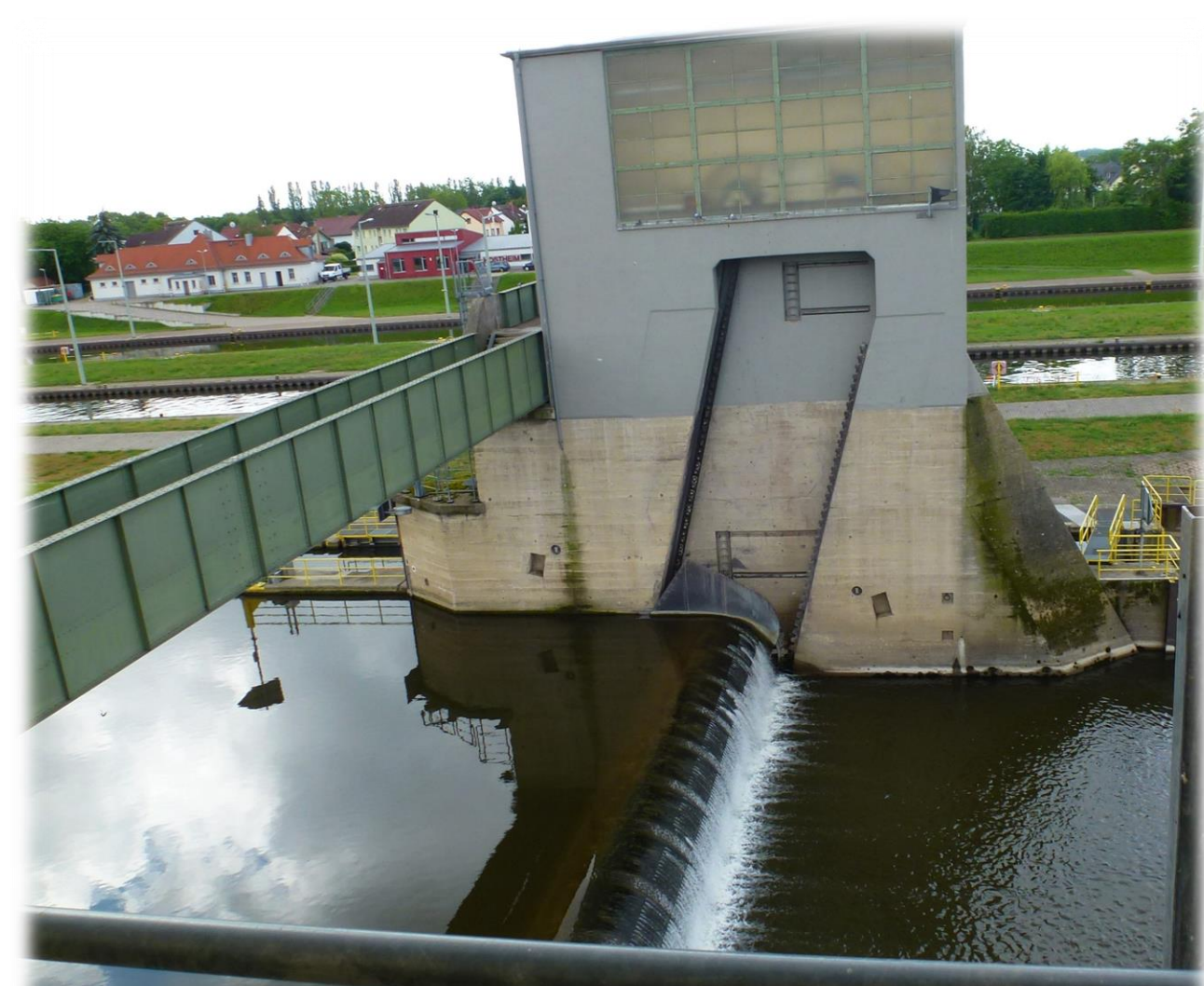
Drei Walzenwehre zur Aufstauung des Mains
