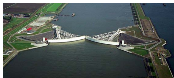
Abbildung 10: Draufsicht auf das geschlossene Sperrwerk [3]
