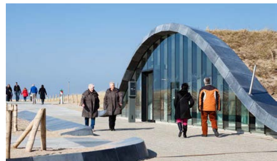
Abbildung 13: Eingang zur Tiefgarage unter der Zeezijde Promenade in Katwijk [4]
