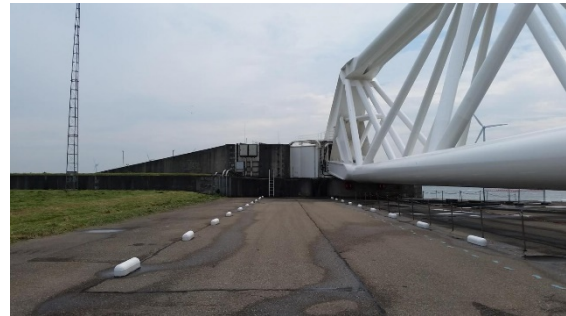
Abbildung 9: Auflager des Maeslant-Sturmwehres
