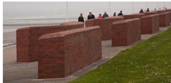
Abbildung 8: Schwallmauern als Bestandteil des Küstenschutzes auf der Insel Norderney
