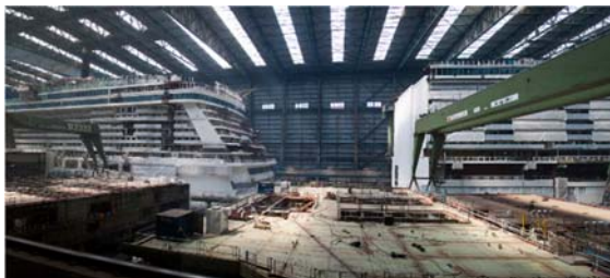
Abbildung 2: Bau eines Kreuzfahrtschiffes in der MEYER WERFT
