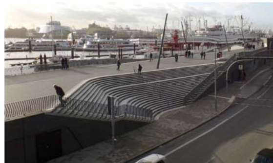
Abbildung 22: Fertige Hochwasserschutzanlage in Finkenwerder [10]
