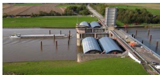
Abbildung 14: Luftaufnahme des Störsperwerks [5]
