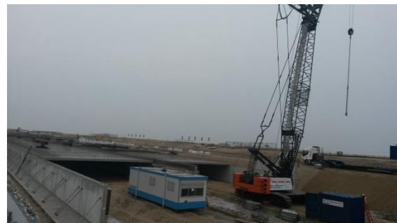
Abb. 13: Fortschritt Bauarbeiten der Tiefgarage
