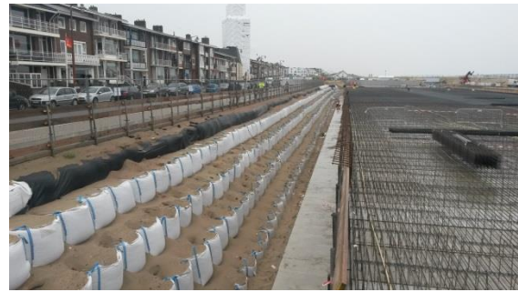
Abb. 15: Böschungsstabilisierung durch Bigpacks
