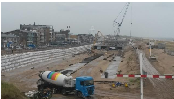
Abb. 14: Übersicht der Baustelle
