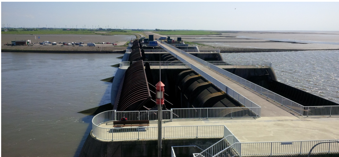
Abbildung 4: Das Eidersperrwerk vom Kontrollstand aus gesehen.
