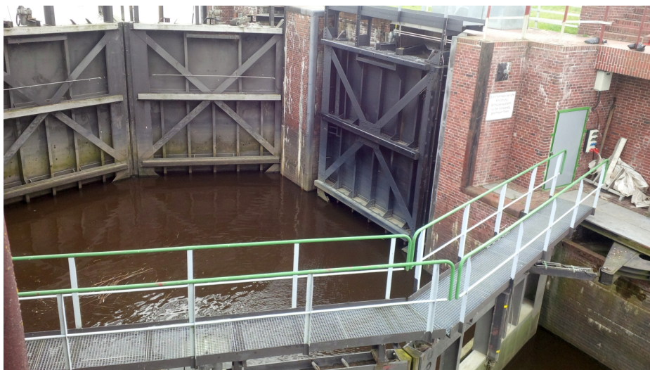
Abbildung 2: Geschlossene Flut- und Ebbtore der seeseitigen Schleusenausfahrt.
