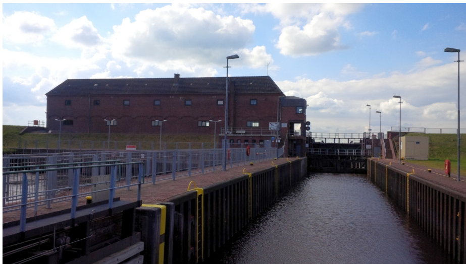
Abbildung 1: Die alte Eiderabdämmung mit der angeschlossenen Schleuse Nordfeld.
