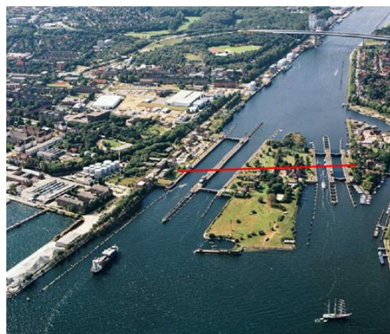
Abbildung 7: Luftbild Schleusenanlage u. Lage Düker [8]
