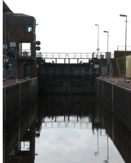
Die Schleusenkammer hat insgesamt eine Länge von 76,00 m, wobei allerdings nur 65,00 m genutzt werden können, und eine Breite von 9,50 m. Bei der Schleusung darf der Wasserstand in der Kammer 6,80 m nicht überschreiten.
