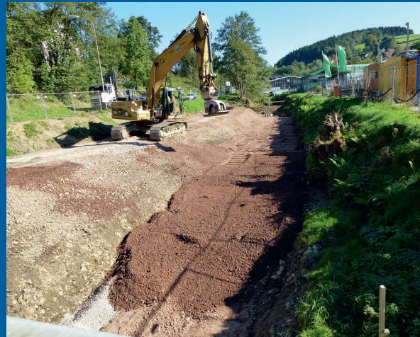
Die Verfüllung des alten Volmebettes an der Stelle des heutigen Parkplatzes im Volme-Freizeit-Park in Kierspe
