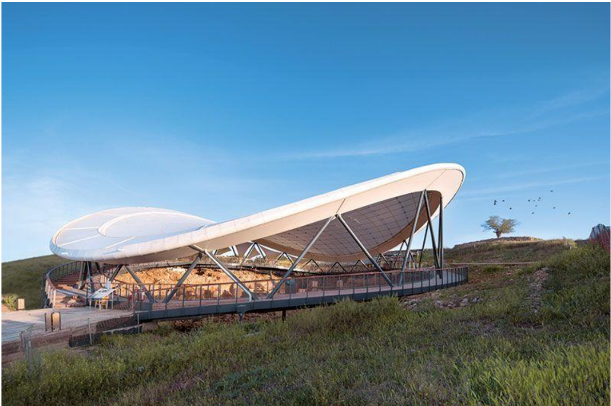
Foto: Schutzdach Göbekli Tepe (Foto: Doğuş Group)
