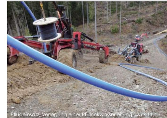
Pflügeinsatz, Verlegung einer PE-Trinkwasserleitung 125 x 11,4
