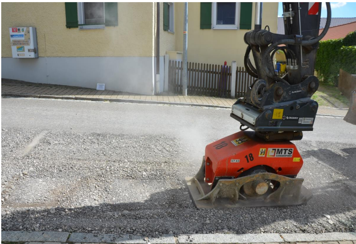
Abbildung 2-31: Erschütterungen durch Bagger-Anbau-Verdichter auf einem Probefeld
