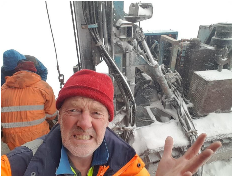
Abbildung 5.2: Einbau von -Inklinometer-Extensometermessrohren bei -20^{\circ}\text{C} und heftigem Schneesturm
