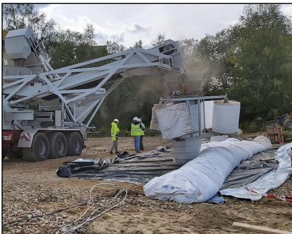
Abbildung 1-1: Herstellung eines Testdeichs
