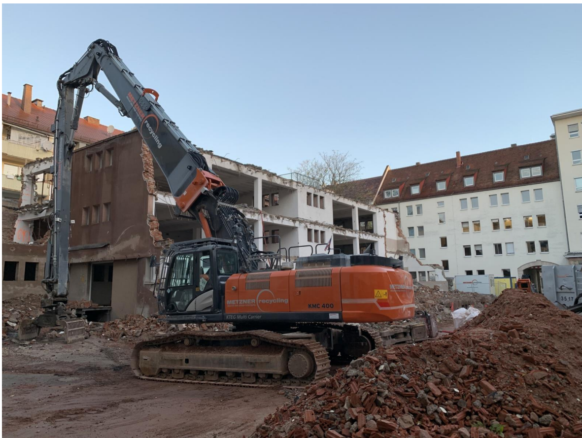
Abbildung 2-33: Erschütterungen beim Rückbau / Abbruch von Gebäuden in Nürnberg
