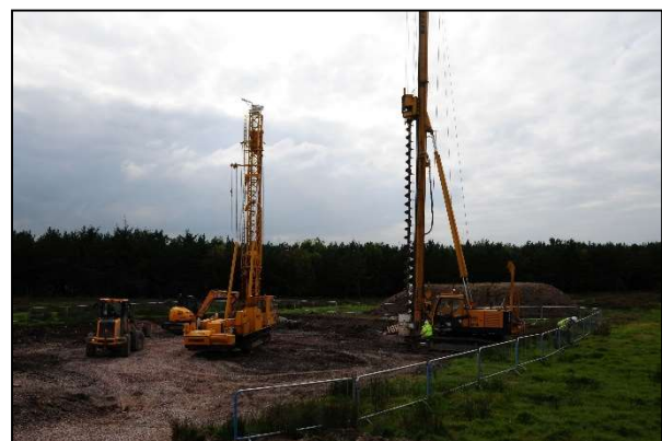
Abbildungen 4-1a und 4-1b: Herstellung der Rüttelstopfsäulen mittels eines Soilmec R412 CFA Schneckenbohrgerätes.
