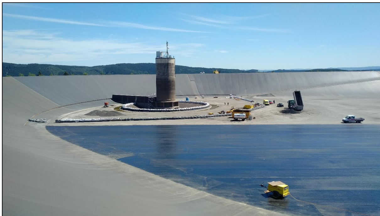
Abbildung 3-2: Oberbecken PSW Rönkhausen – Sanierung 2018
