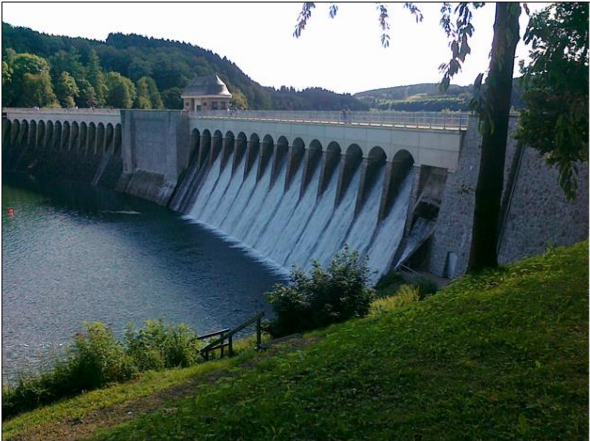
Abbildung 3-1: Bild 2: Listertalsperre – Überlauf im Sommer 2012.
