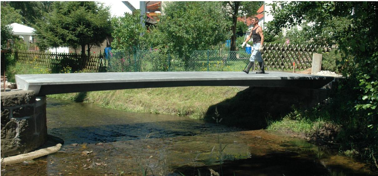
Bild 10 b: Ansicht der 9 m langen Plattenbalkenbrücke
