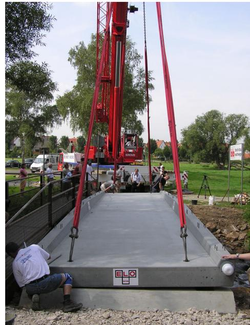
Bilder 9a und b: Montage der ersten UHPC-Fuß- und Radwegbrücke zum Schwimmbad der Gemeinde Niestetal
