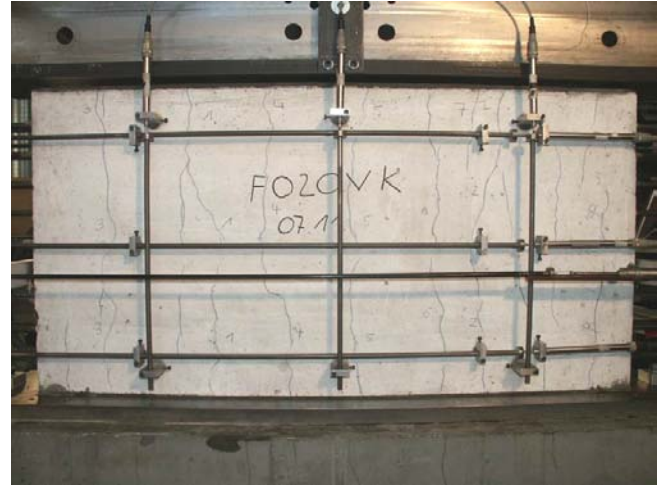
Bild A.2-96. Rissbild der Scheibe F020VK (Ansicht Süd) Fig. A.2-96. Crack pattern of Panel F020VK (view south)
