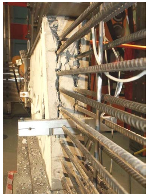
Bild A.3-21. Bruchbild der Scheibe F020VK2 (Ansicht West) Fig. A.3-21. Panel F020VK2 at failure (view west)
