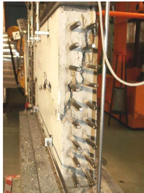
Bild A.2-80. Bruchbild der Scheibe F000VK (Ansicht West) Fig. A.2-80. Panel F000VK at failure (view west)
