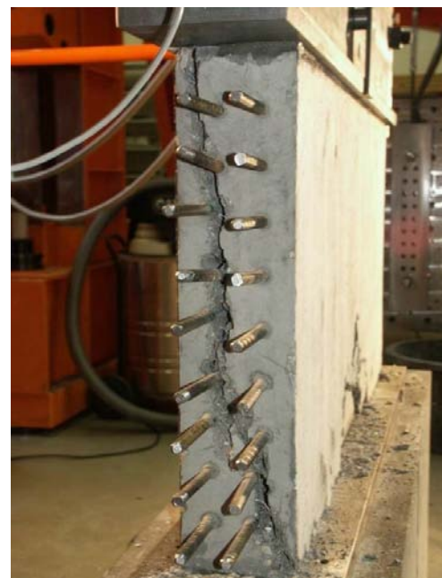
Bild A.3-5. Bruchbild der Scheibe F000VK2 (Ansicht Ost) Fig. A.3-5. Panel F000VK2 at failure (view east)
