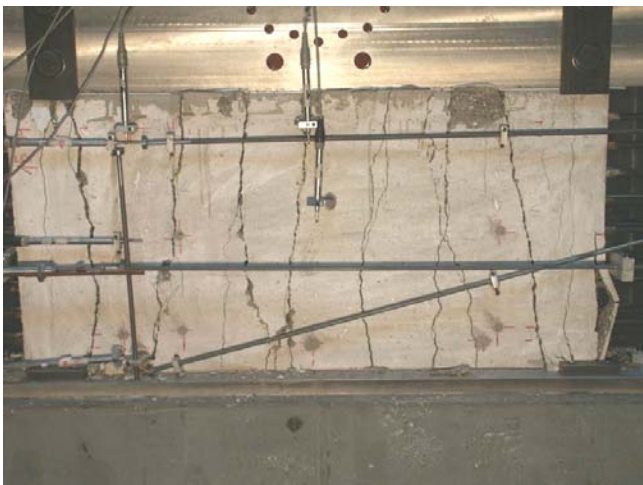
Bild A.1-40. Bruchbild der Scheibe 250T (Ansicht Nord) Fig. A.1-40. Panel 250T at failure (view north)
