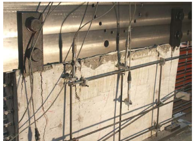
Bild A.1-25. Bruchbild der Scheibe 050T (Ansicht Nordost) Fig. A.1-25. Panel 050T at failure (view north-east)
