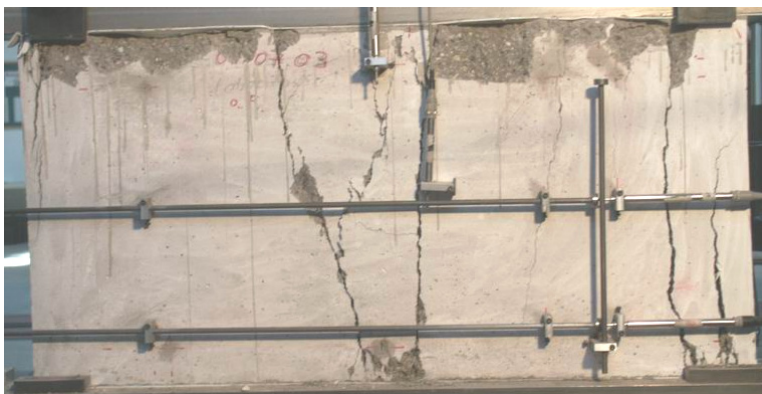
d) unbewehrte Scheibe T, nur auf Druck belastet, vertikale Rissbildung während der Druckbelastung, Bruch direkt unterhalb der PTFE-Folie d) plain concrete Panel T, compression loaded only, vertical cracking under compression loading, failure directly beneath the PTFE-foil
