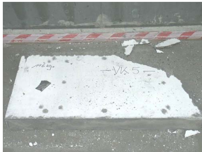
Bild A.4-2. Bruchbild der Scheibe VK5 (Ansicht Nord) Fig. A.4-2. Panel VK5 at failure (view north)
