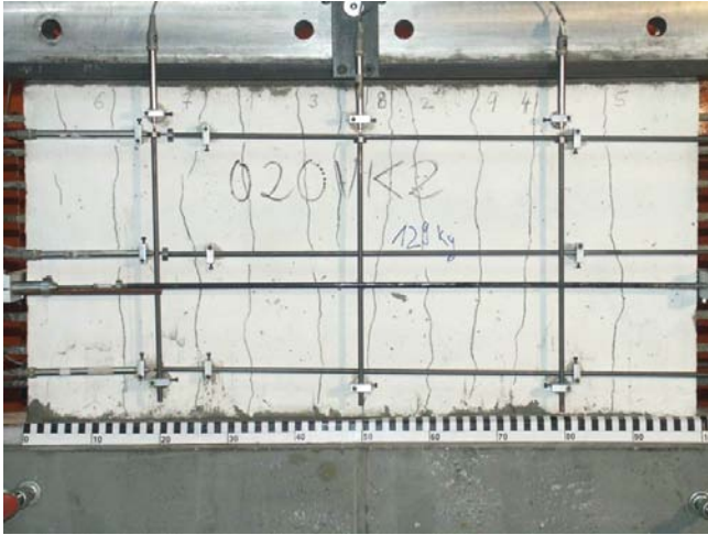
Bild A.4-25. Rissbild der Scheibe 020VK2 (Ansicht Nord) Fig. A.4-25. Crack pattern of Panel 020VK2 (view north)
