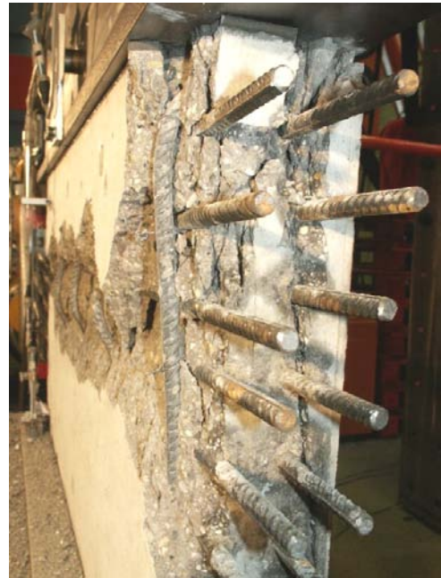
Bild A.2-25. Bruchbild der Scheibe 000VK2 (Ansicht West) Fig. A.2-25. Panel 000VK2 at failure (view west)
