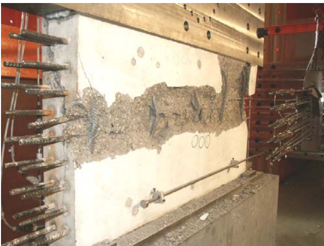
Bild A.2-118. Bruchbild der Scheibe 000 (Ansicht Nord) Fig. A.2-118. Panel 000 at failure (view north)
