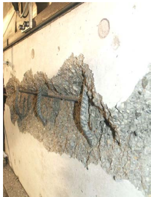
Bild A.2-27. Bruchbild der Scheibe 000VK2 Ansicht Nord) Fig. A.2-27. Panel 000VK2 at failure (view north)
