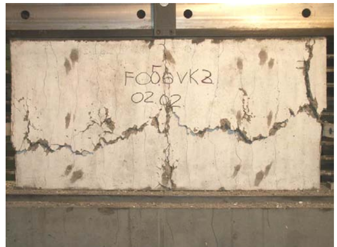
Bild A.3-29. Bruchbild der Scheibe F050VK2 (Ansicht Süd) Fig. A.3-29. Panel F050VK2 at failure (view south)
