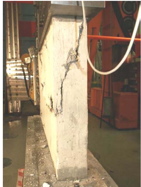
Bild A.2-75. Bruchbild der Scheibe FVK (Ansicht West) Fig. A.2-75. Panel FVK at failure (view west)
