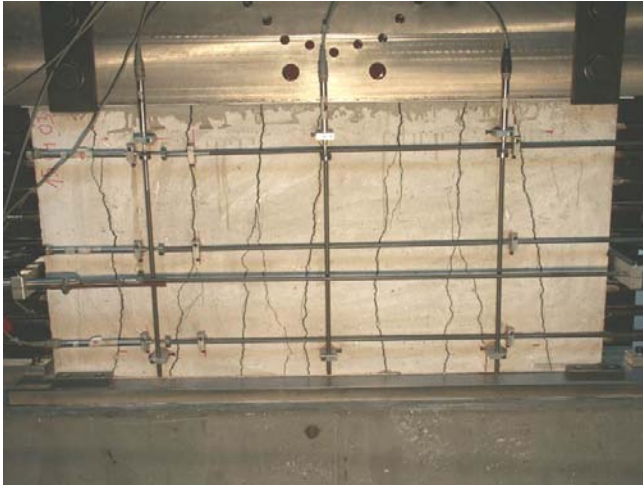
Bild A.1-38. Rissbild der Scheibe 250T (Ansicht Nord) Fig. A.1-38. Crack pattern of Panel 250T (view north)
