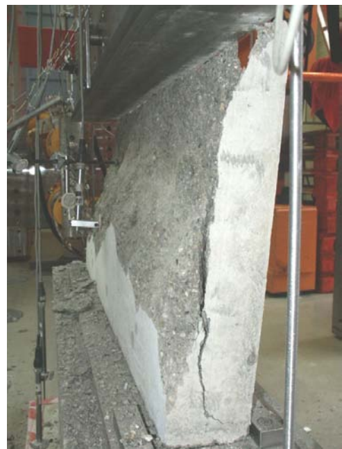
Bild A.2-5. Bruchbild der Scheibe VK1 (Ansicht West) Fig. A.2-5. Panel VK1 at failure (view west)
