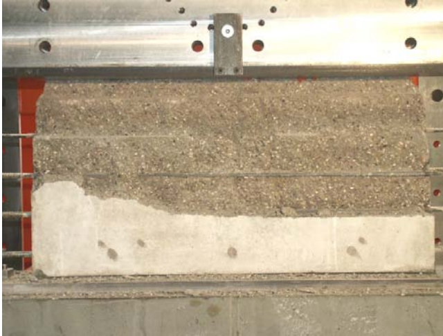
Bild A.2-121. Bruchbild der Scheibe Q000VK (Ansicht Nord) Fig. A.2-121. Panel Q000VK at failure (view north)
