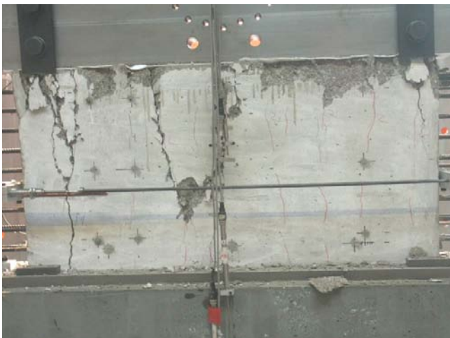
Bild A.1-72. Bruchbild der Scheibe F075T (Ansicht Nord) Fig. A.1-72. Panel F075T at failure (view north)
