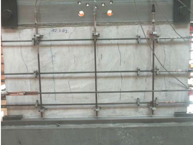
Bild A.1-86. Rissbild der Scheibe F250T (Ansicht Nord) Fig. A.1-86. Crack pattern of Panel F250T (view north)
