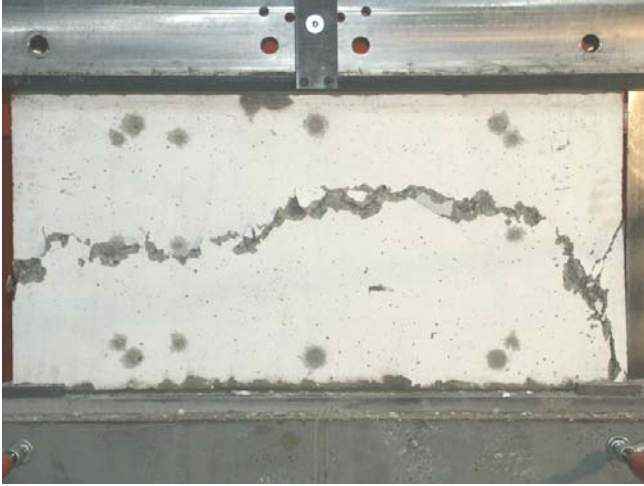
Bild A.4-54. Bruchbild der Scheibe FVK2 (Ansicht Nord) Fig. A.4-54. Panel FVK2 at failure (view north)
