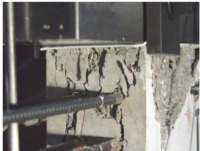
Bild A.1-5. Bruchbild der Scheibe 000T (Ansicht West) Fig. A.1-5. Panel 000T at failure (view west)
