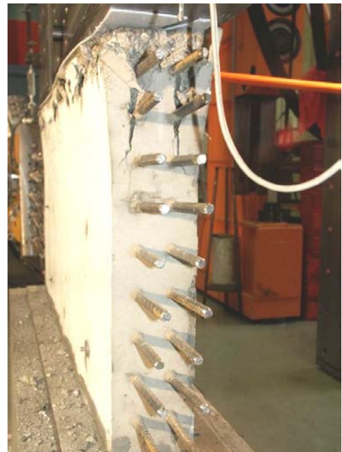
Bild A.3-9. Bruchbild der Scheibe F000VKT (Ansicht West) Fig. A.3-9. Panel F000VKT at failure (view west)
