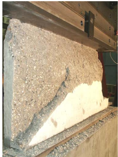
Bild A.2-16. Bruchbild der Scheibe VK4 (Ansicht West) Fig. A.2-16. Panel VK4 at failure (view west)
