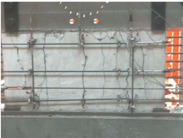
Bild A.1-88. Bruchbild der Scheibe F250T (Ansicht Nord) Fig. A.1-88. Panel F250T at failure (view north)
