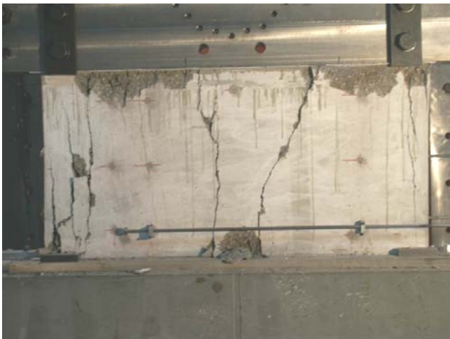
Bild A.1-91. Bruchbild der Scheibe T (Ansicht Nord) Fig. A.1-91. Panel T at failure (view north)
