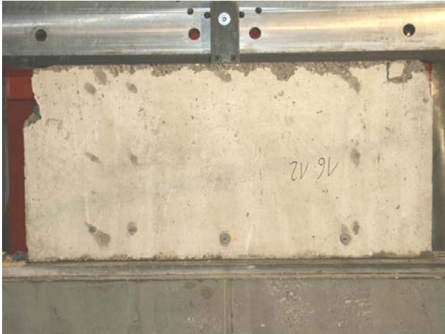
Bild A.2-15. Bruchbild der Scheibe VK4 (Ansicht Nord) Fig. A.2-15. Panel VK4 at failure (view north)
