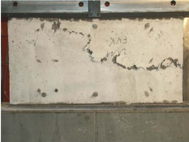
Bild A.2-74. Bruchbild der Scheibe FVK (Ansicht Nord) Fig. A.2-74. Panel FVK at failure (view north)
