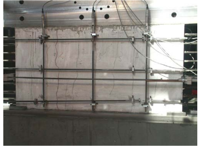
Bild A.1-101. Rissbild der Scheibe 015 (Ansicht Süd) Fig. A.1-101. Crack pattern of Panel 015 (view south)
