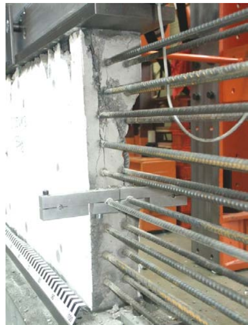
Bild A.4-20. Bruchbild der Scheibe 005VK3 (Ansicht West) Fig. A.4-20. Panel 005VK3 at failure (view west)
