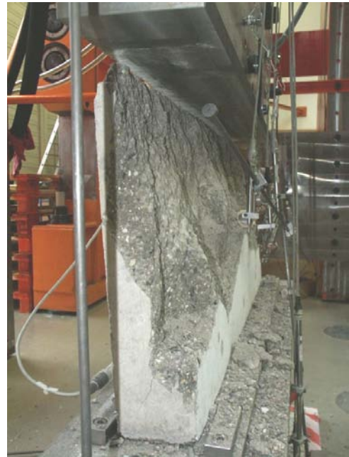
Bild A.2-3. Bruchbild der Scheibe VK1 (Ansicht Ost) Fig. A.2-3. Panel VK1 at failure (view east)
