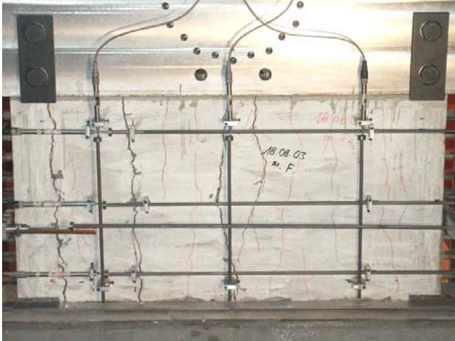
Bild A.1-108. Rissbild der Scheibe F150 (Ansicht Nord) Fig. A.1-108. Crack pattern of Panel F150 (view north)
