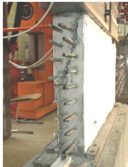
Bild A.4-62. Bruchbild der Scheibe F000VK4 (Ansicht Ost) Fig. A.4-62. Panel F000VK4 at failure (view east)
