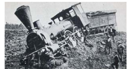
Entgleisung der Amstetten durch Ermüdungsbruch des Radreifens 1875 Quelle: wikipedia.de
