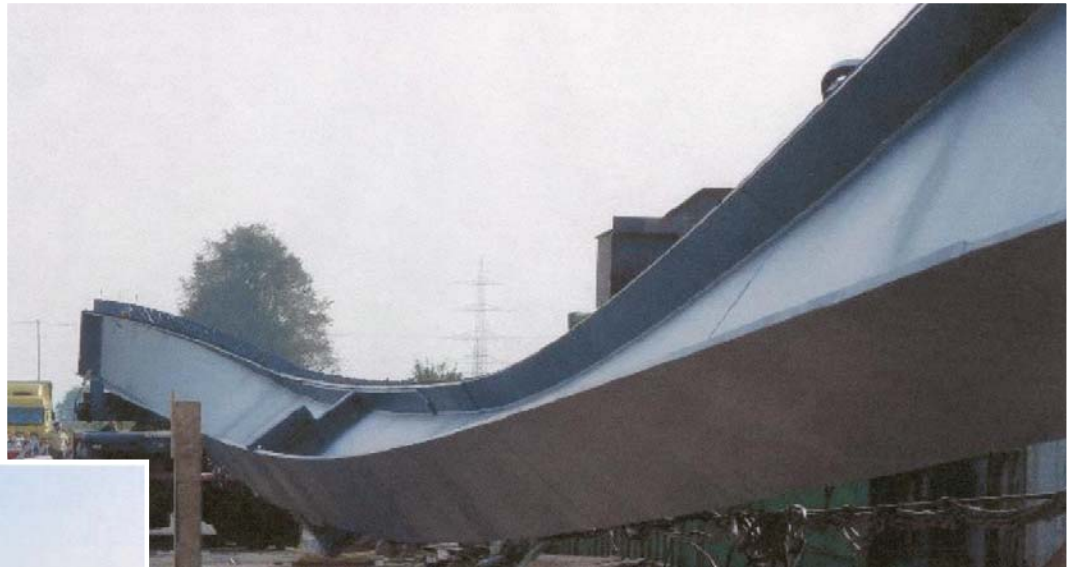
Stabilitätsversagen eines Verbundbrückenträgers infolge Eigengewicht nach Lösen der Kopplungselemente, A4 bei Düren
