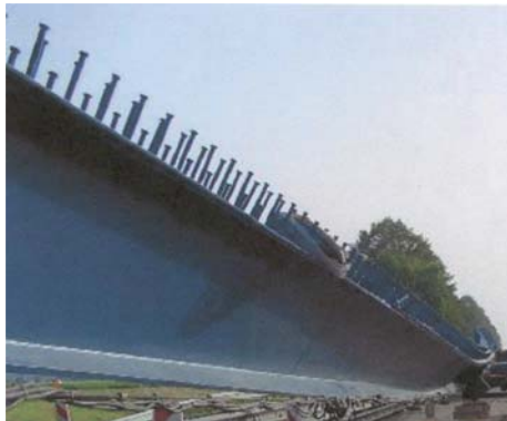
Stabilitätsversagen eines Verbundbrückenträgers infolge Eigengewicht nach Lösen der Kopplungselemente, A4 bei Düren
