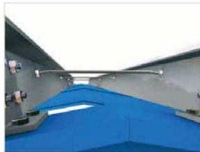
Dachschubkopplung mit Firstblech oder Firstkappe
