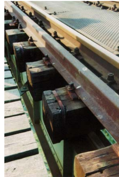
Lagerung von Schienenstrang und Entgleisungsschutz auf der Schwelle
